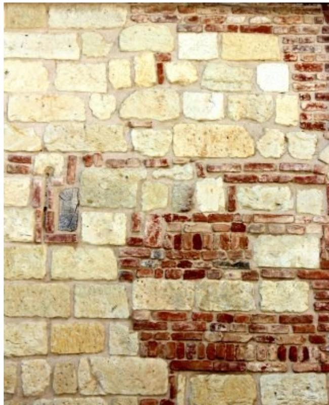
*Figura 6: paramenti murari misti a fasce di laterizi e blocchi di arenaria chiara*
